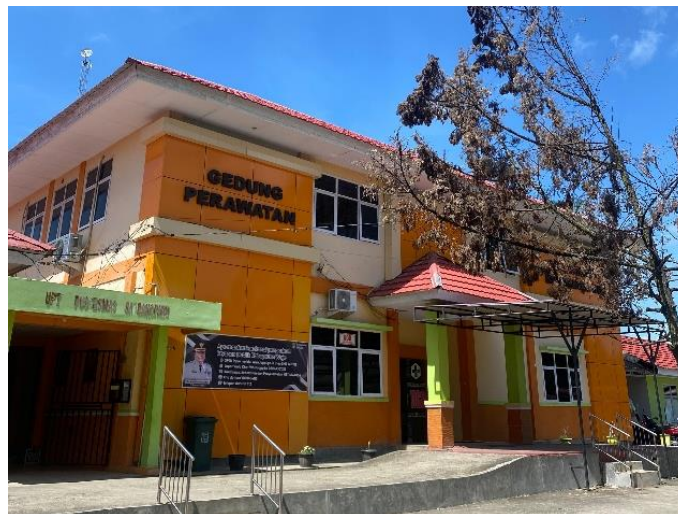
Gambar 2 Bangunan I Puskesmas
